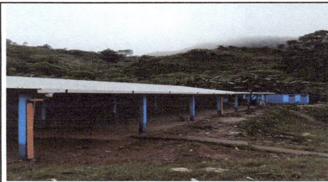
Foto 2: Los canales fueron instalados
