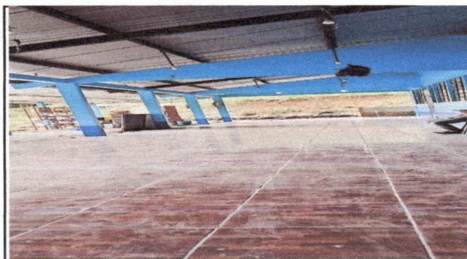
Foto 3: El piso ceramico fue colocado en el corredor
